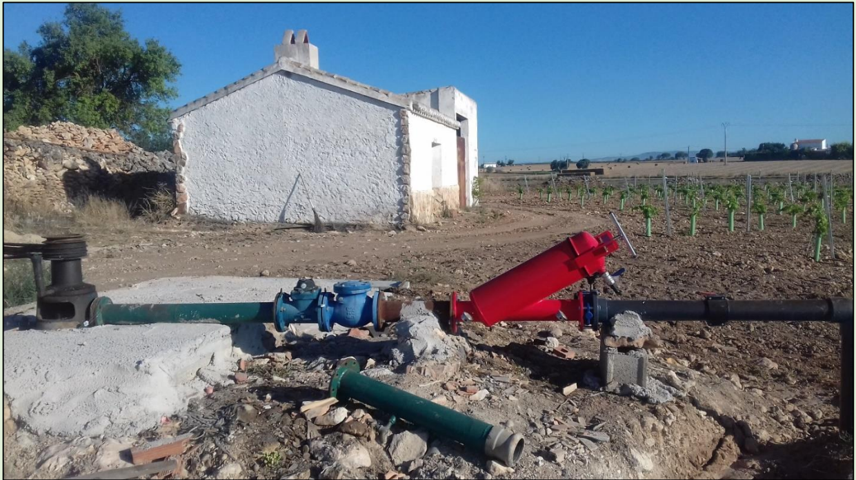
Instalación precintada por el personal técnico de la CUAS Mancha Occidental I
